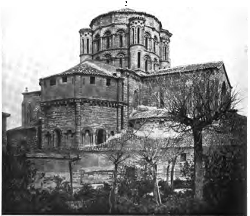
Fig. 49. — Clocher de transept de forme polygonale couvert en coupole à la cathédrale de Toro. Espagne.
